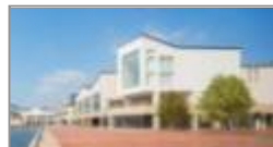
ハーバーテラスSASEBO迎賓館
